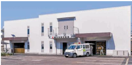
△市役所前の防災備蓄倉庫 (出典：広報おけがわ2022年5月号)
