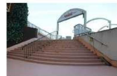
△階段により、車いす・ベビーカー利用者はデッキを実質使えない。
